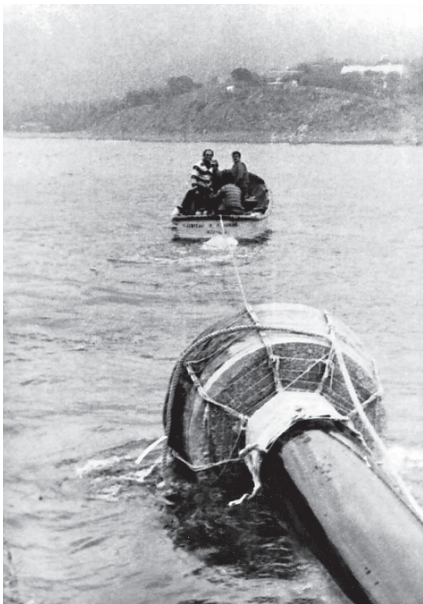
Транспортировка установки на место работы.
