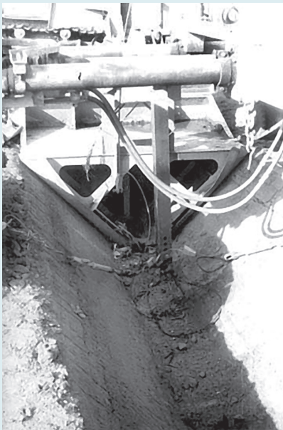
Рис. 4. Скользящая грейдерная опалубка и опытный лоток
